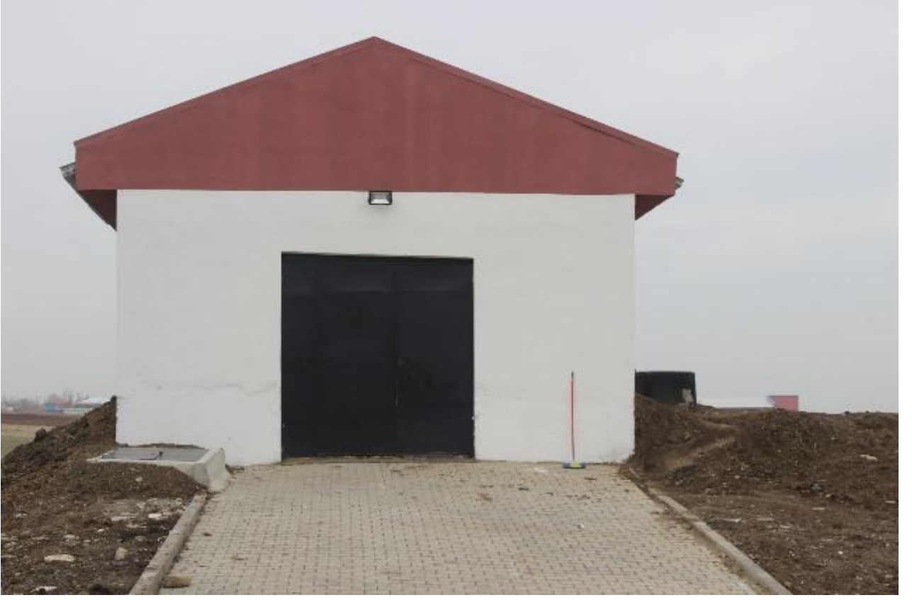
Resim 2 Kampüs Altyapı ( Terfi İstasyonu)
